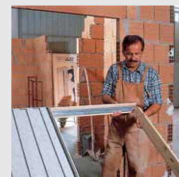
2. Introducir el montante en el travesaño superior.
